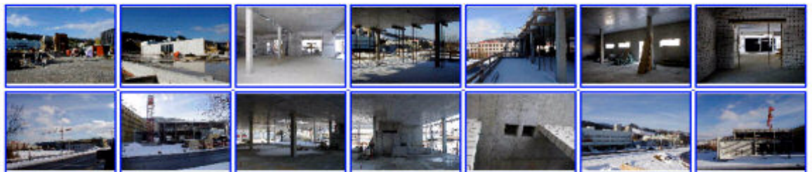
Logistikcenter Spreitenbach (2) Gebäude/Rohbau 1 Baumeisterarbeiten
